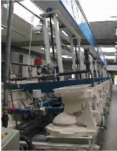
Linea di produzione manufatti ceramici con sistema di inclinazione oleodinamica multipla sincronizzata senza collegamento meccanico
